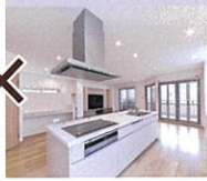
全水廻り機器取替工事
